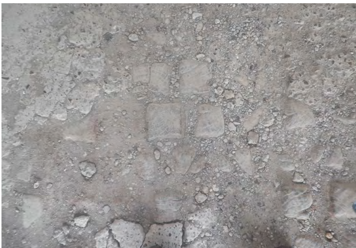
Kolni prolaz 17 - tragovi izvornog popločenja drvenim kockama
