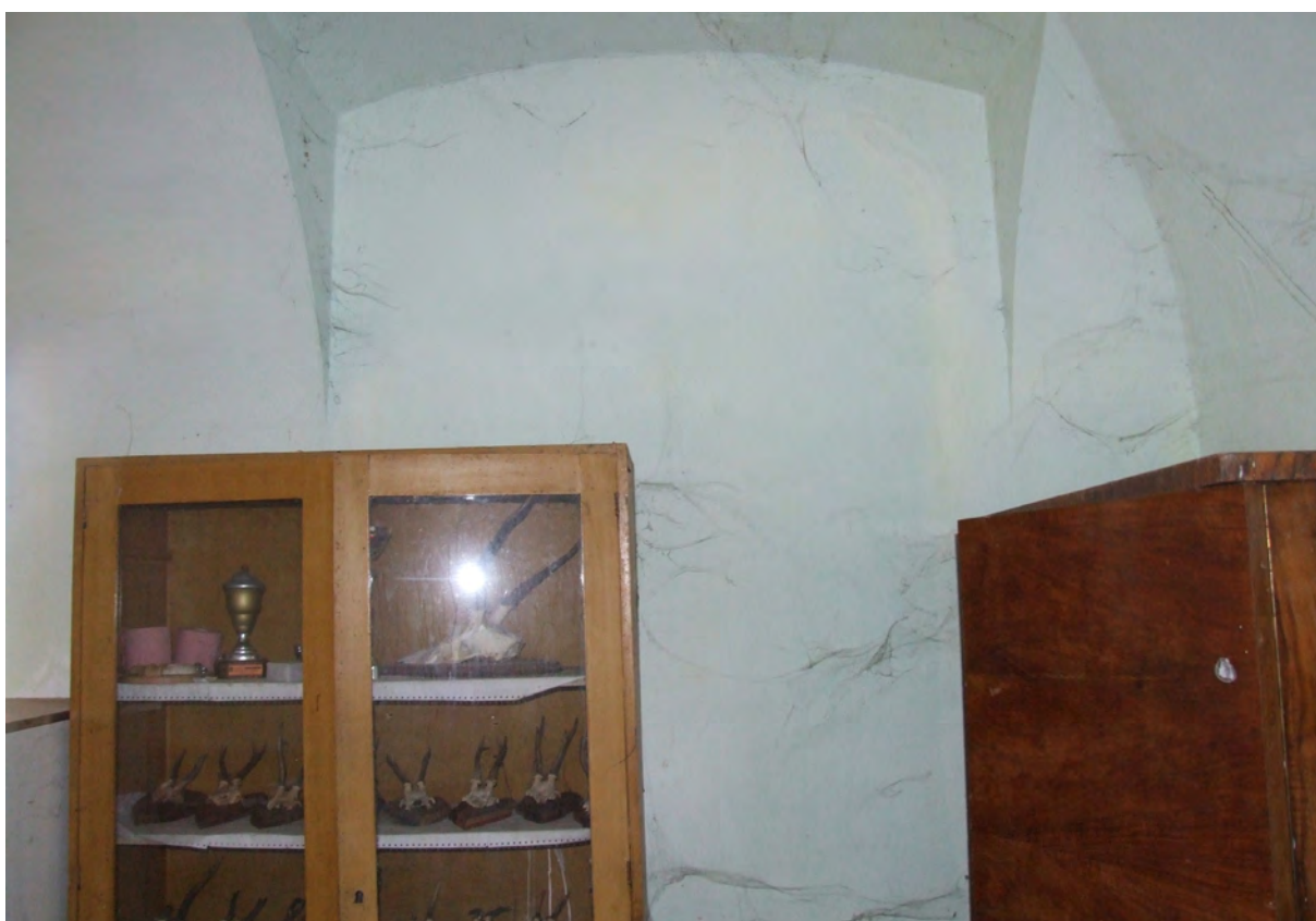
Prostorija I - sjeverni zid, zazidani prozor
