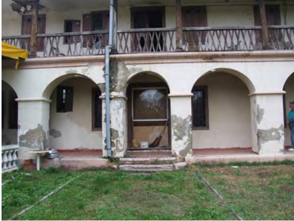
Detalj trijema na južnom pročelju južnog krila
