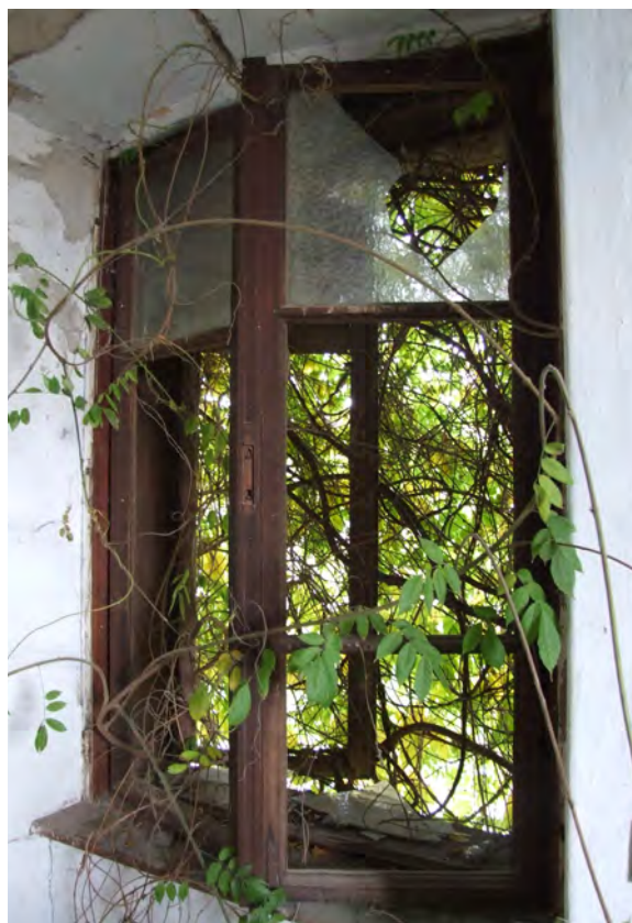
Prostorija 39 - prozor na južnom zidu
