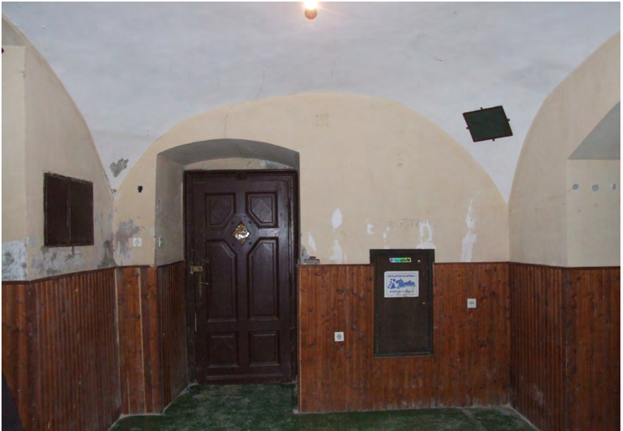
Prostorija 16 - pogled prema sjeveru i ulaznim vratima
