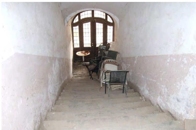
Stubište 48 - drvena gazišta
