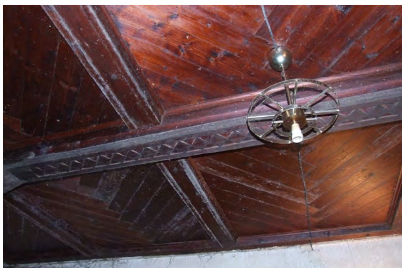
Prostorija 29 - drvena oplata stropa
