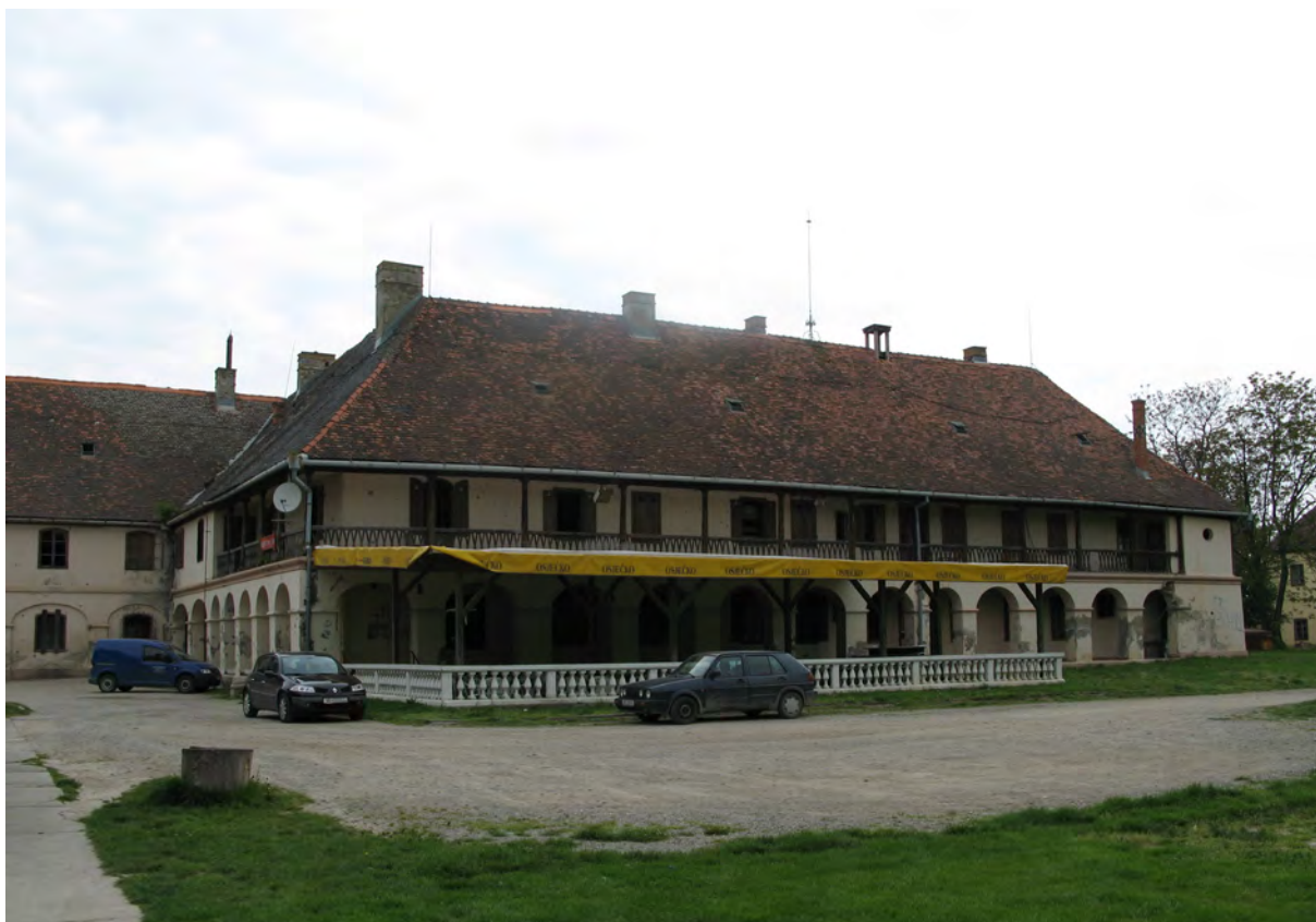
Južno pročelje južnog krila
