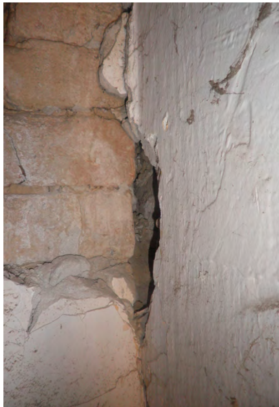
Stubište 48 - trag "čvrste" reške
