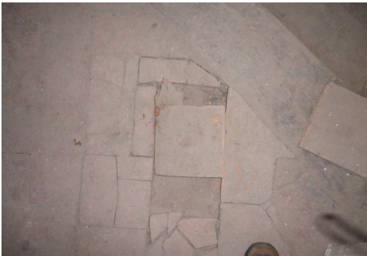
Stubište 48 - detalj popločenja opekom
