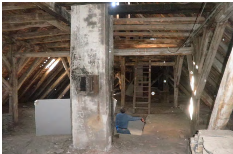
Južno krilo- krovište, pogled prema istoku
