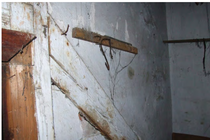
Prostorija 65 - detalj kanatne konstrukcije
