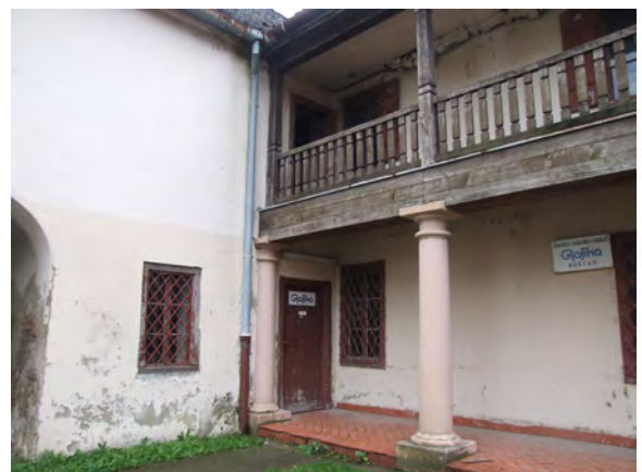
Detalj trijema na sjevernom pročelju južnog krila
