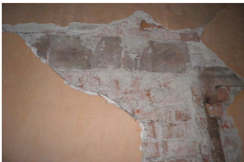
Prostorija 55 - detalj kanatne konstrukcije
