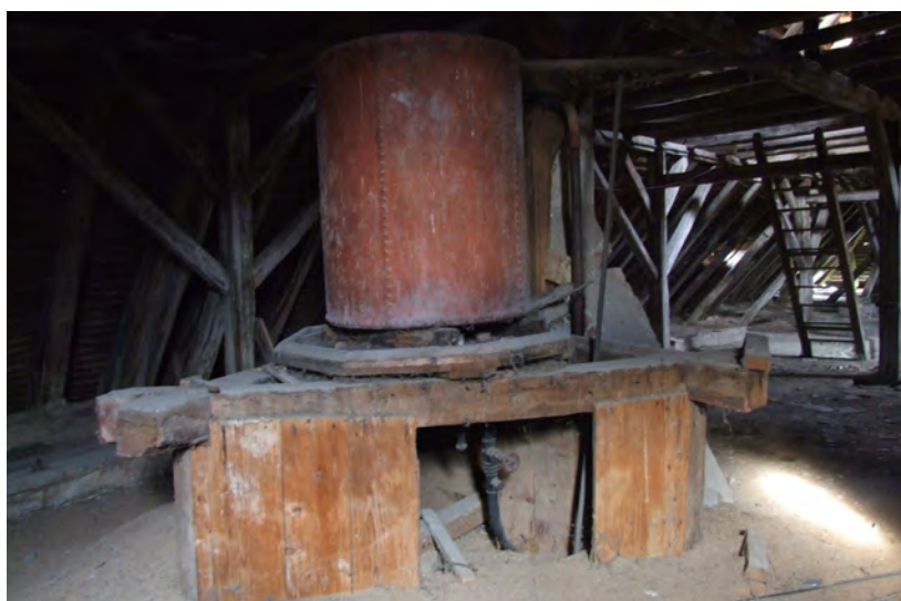
Južno krilo- krovište, središnji dio, kotao za grijanje vode
