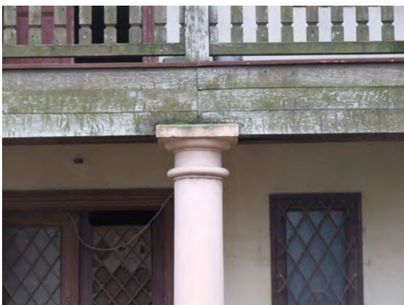
Detalj stupa na sjevernom pročelju južnog krila
