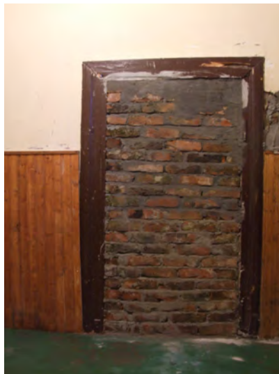
Prostorija 13 - novo zazidani otvor prema prostoriji 11
