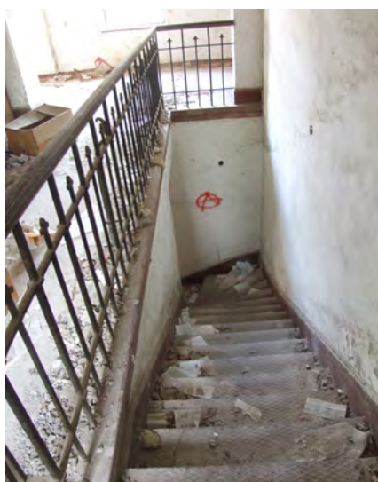
Stubište 41 - stubišni krak
