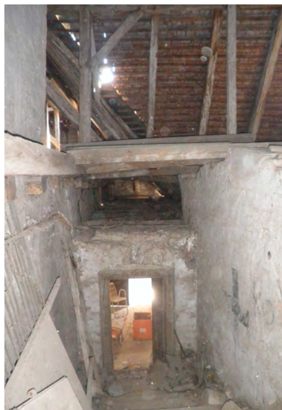
Zapadno krilo- krovšte, pogled prema ulazu (trijem 49)
