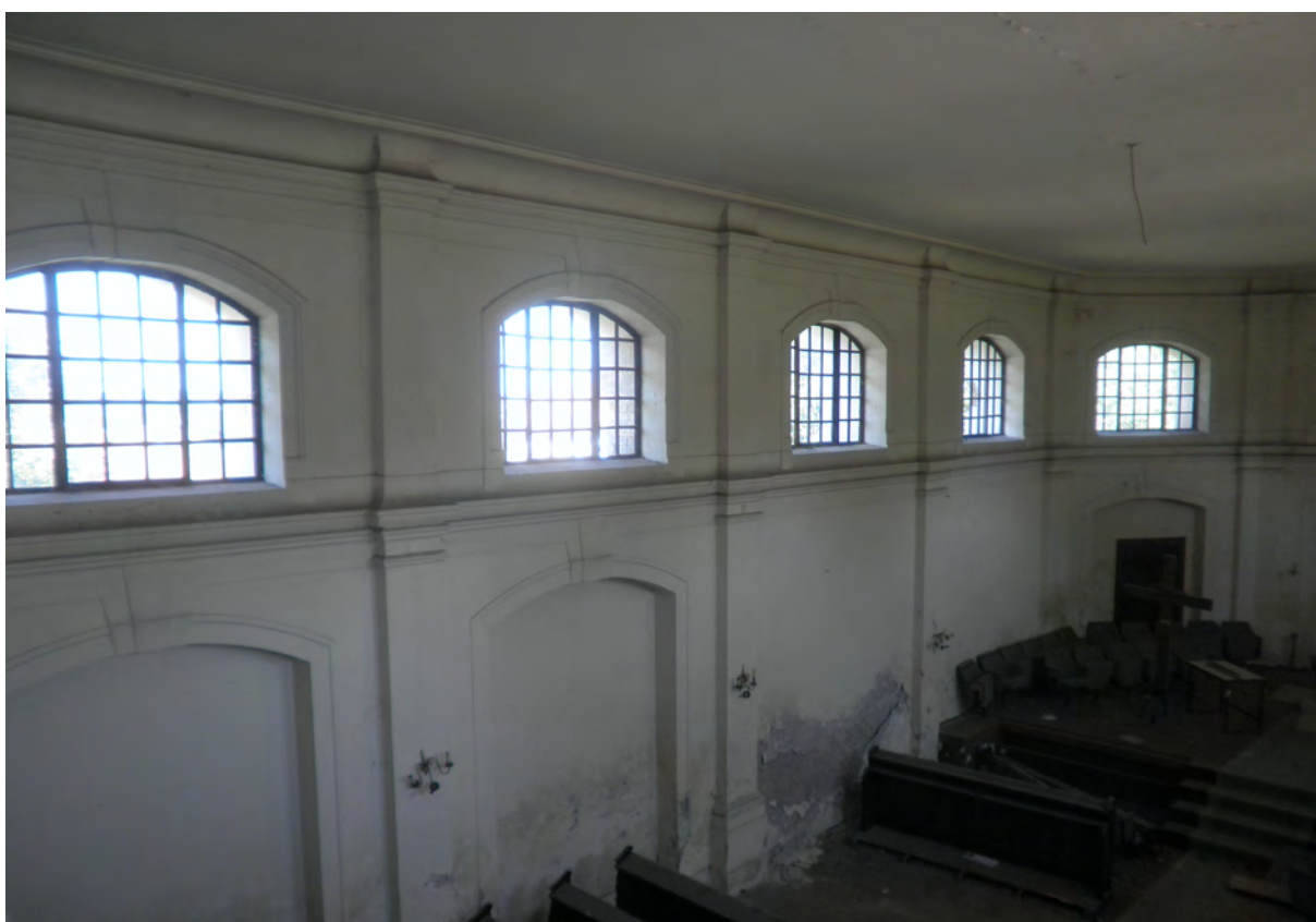
Crkva - pogled prema sjeveru
