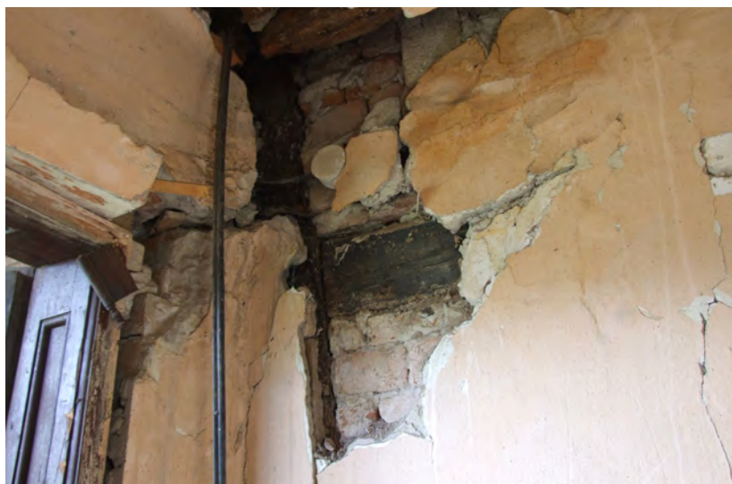
Prostorija 69 - detalj kanatne konstrukcije
