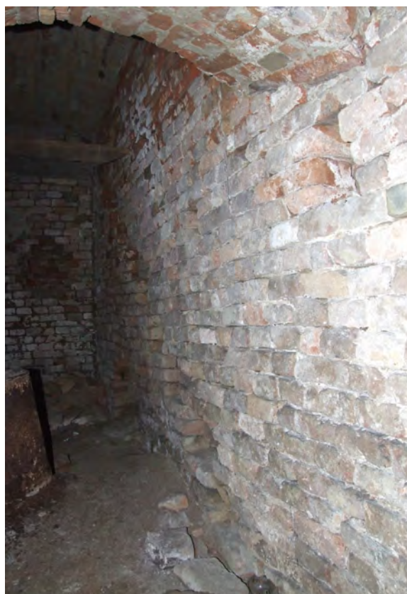
Podrum Z - dokinuto stubište na zapadu
