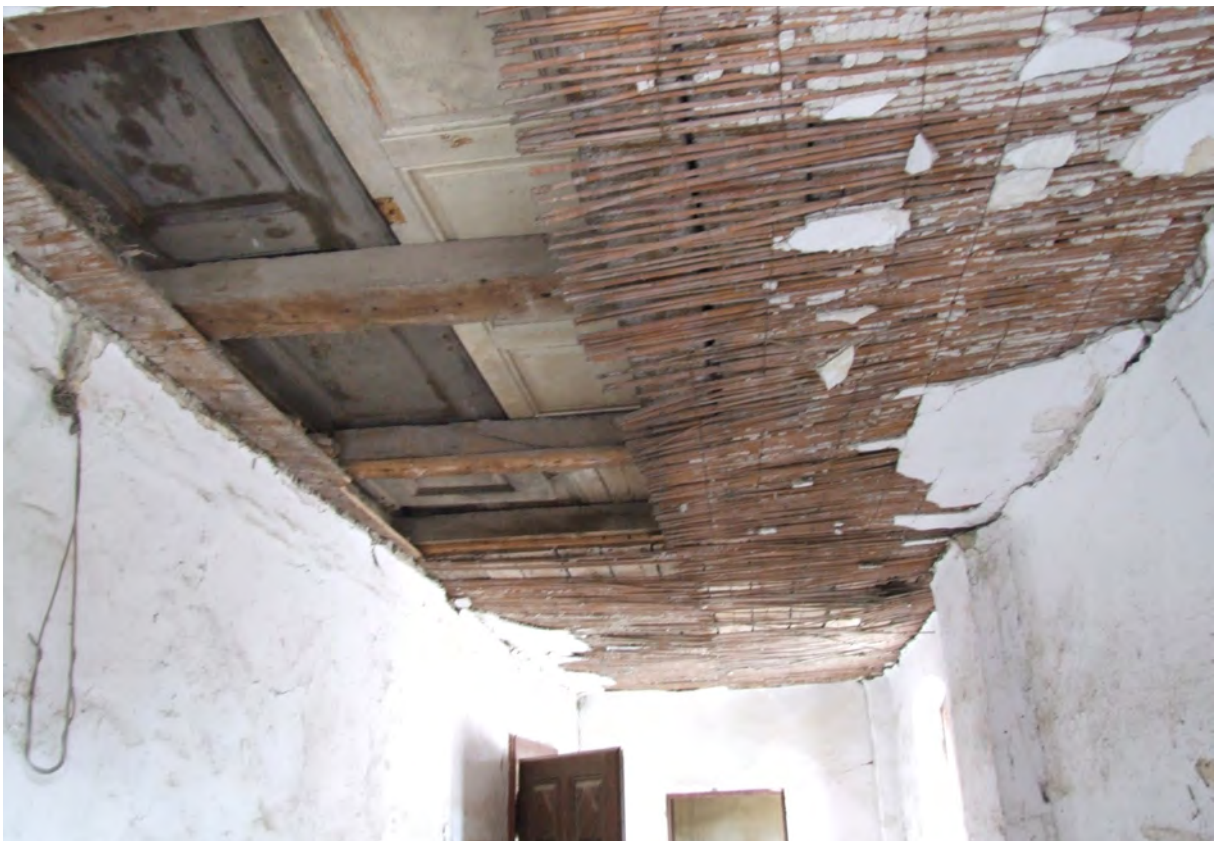
Trijem 42 - pogled na oštećeni strop
