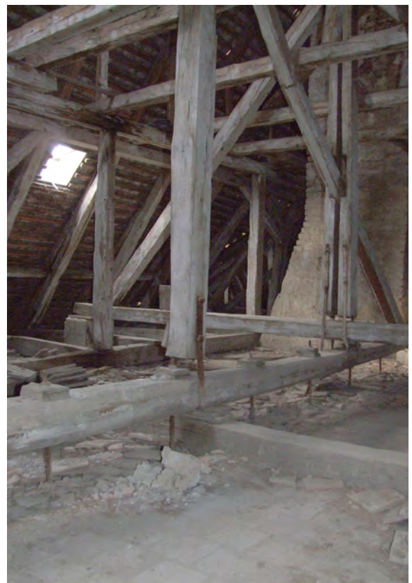
Zapadno krilo- krovšte, istočni dio
