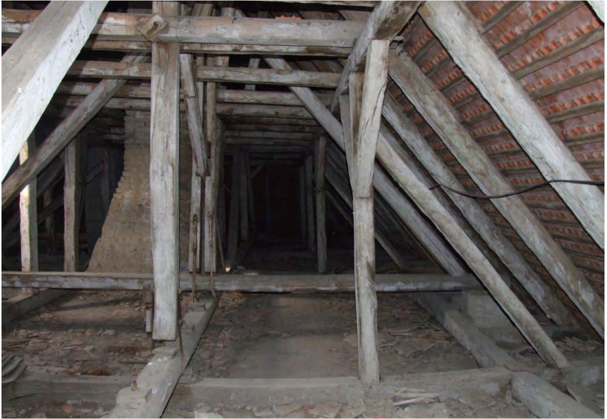
Zapadno krilo- krovšte, istočni dio, pogled prema sjeveru
