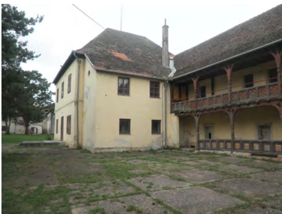
Južno pročelje "Malog" dvorca
