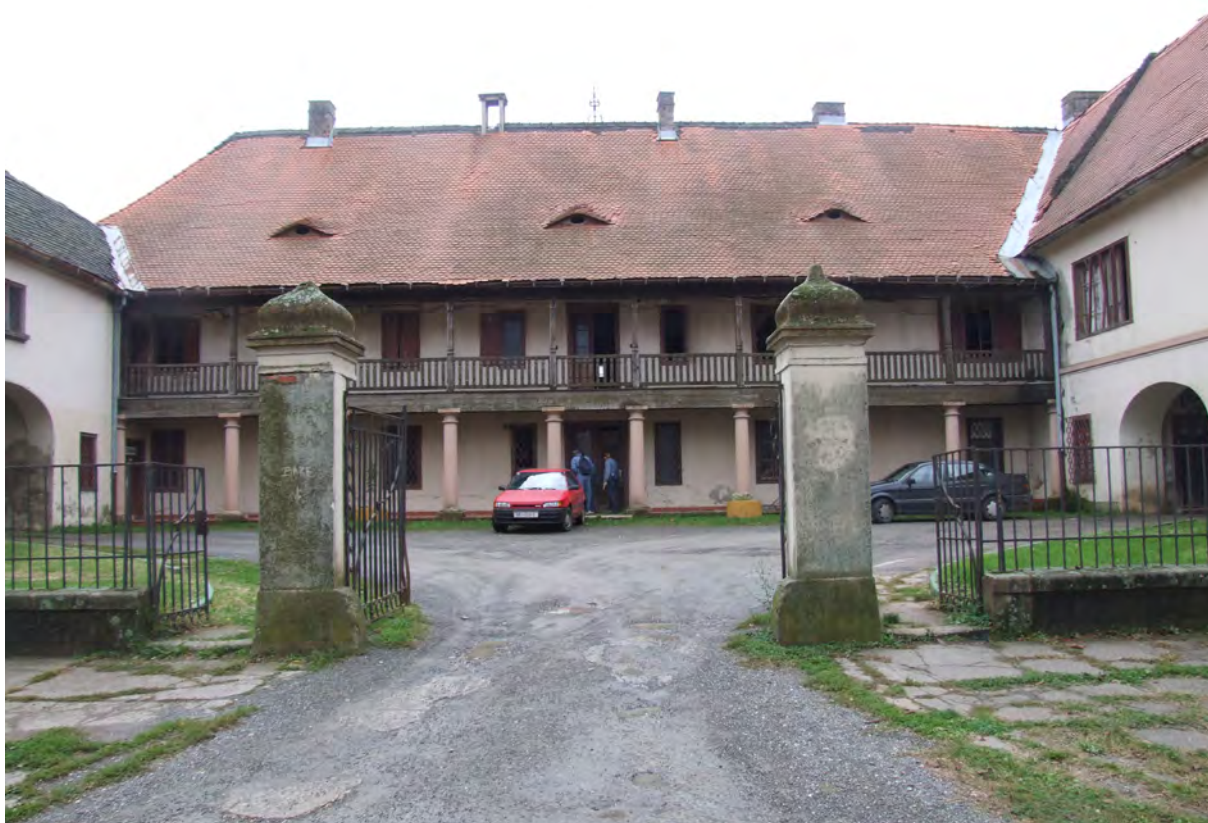
Sjeverno pročelje južnog krila i ulazno dvorište
