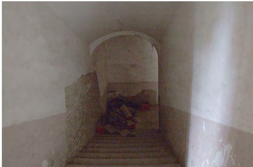
Stubište 48 - pogled s kata na podest
