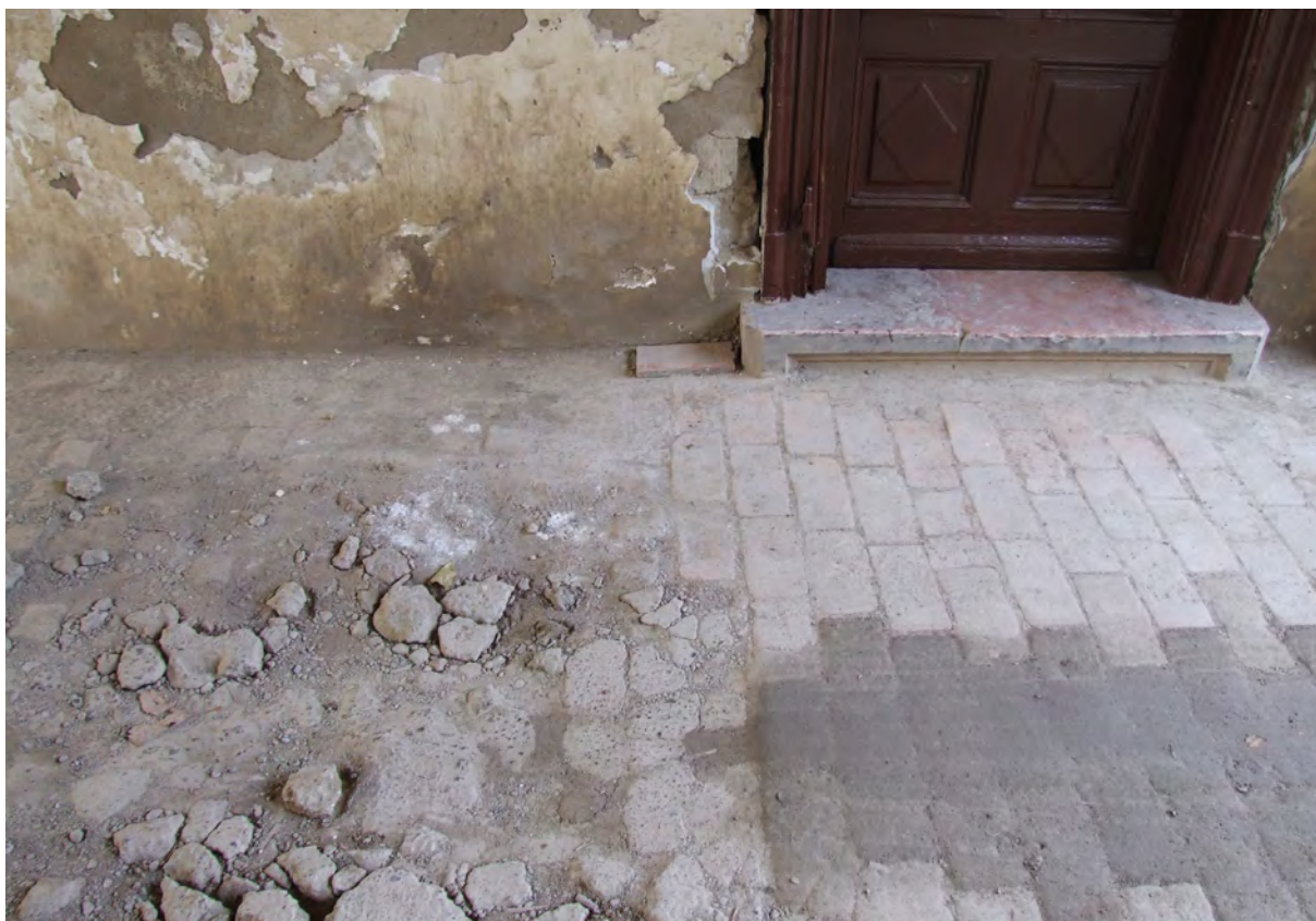
Kolni prolaz 17 - detalj popločenja
