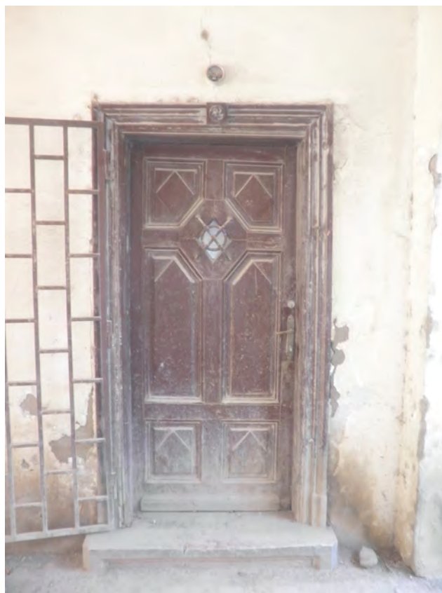
Kolni prolaz 17 - pogled na vrata prostorije 16
