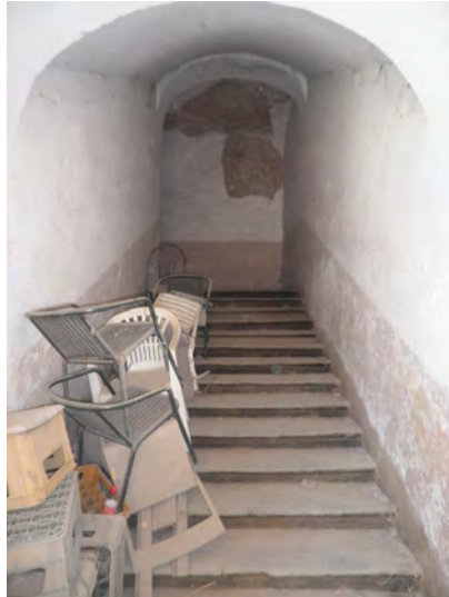
Stubište 48 - pogled iz prizemlja prema podestu
