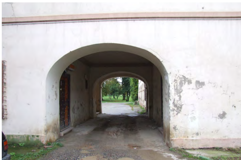
Kolni prolaz 17 - pogled prema zapadu
