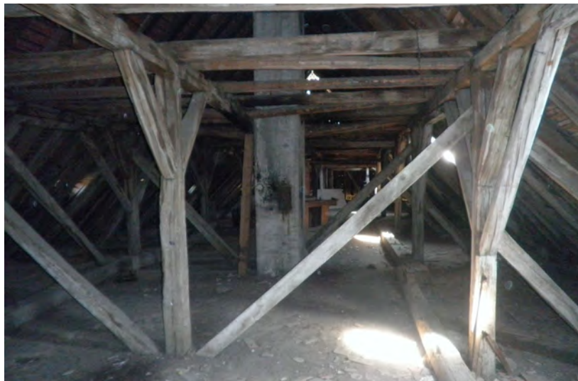
Južno krilo- krovište, pogled prema istoku
