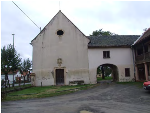
Zapadno pročelje crkve i spojni hodnik
