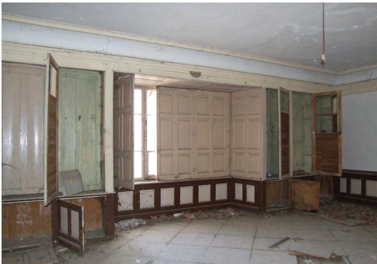
Prostorija 51 - pogled prema istoku i prozoru s drvenim kopcima
