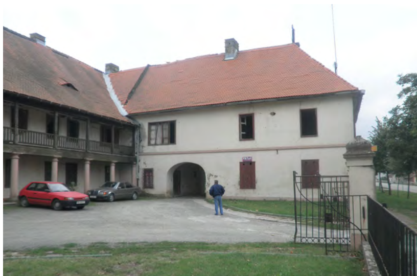
Istočno pročelje zapadnog krila
