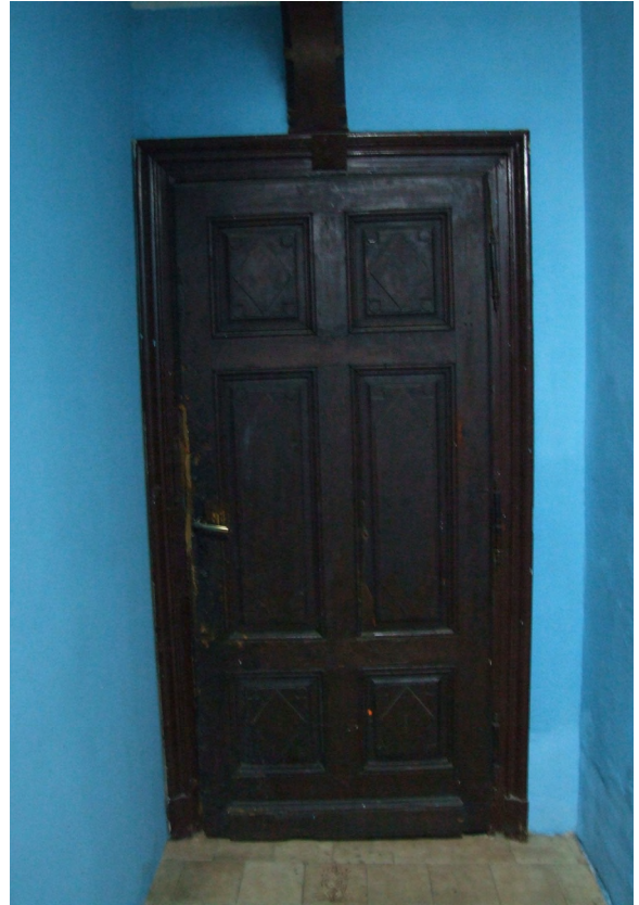
Prostorija 27 - vrata prema stubištu
