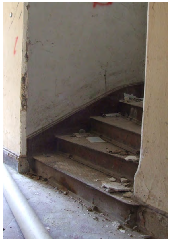
Stubište 5 - stubišni krak
