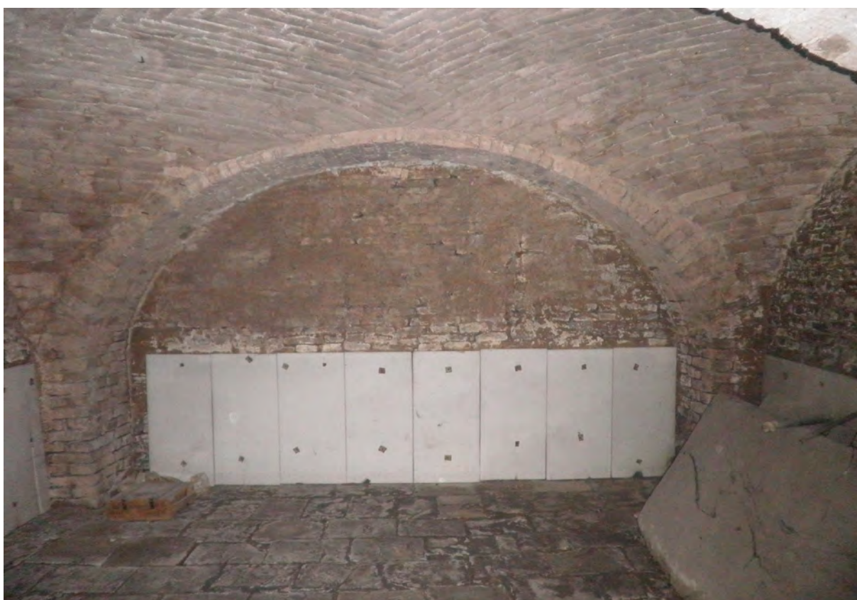
Podrum J - zapadni zid
