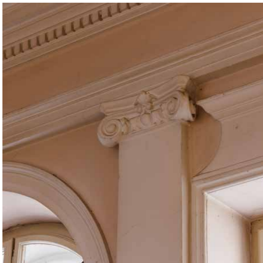
Zrcalni strop iznad stubišta
