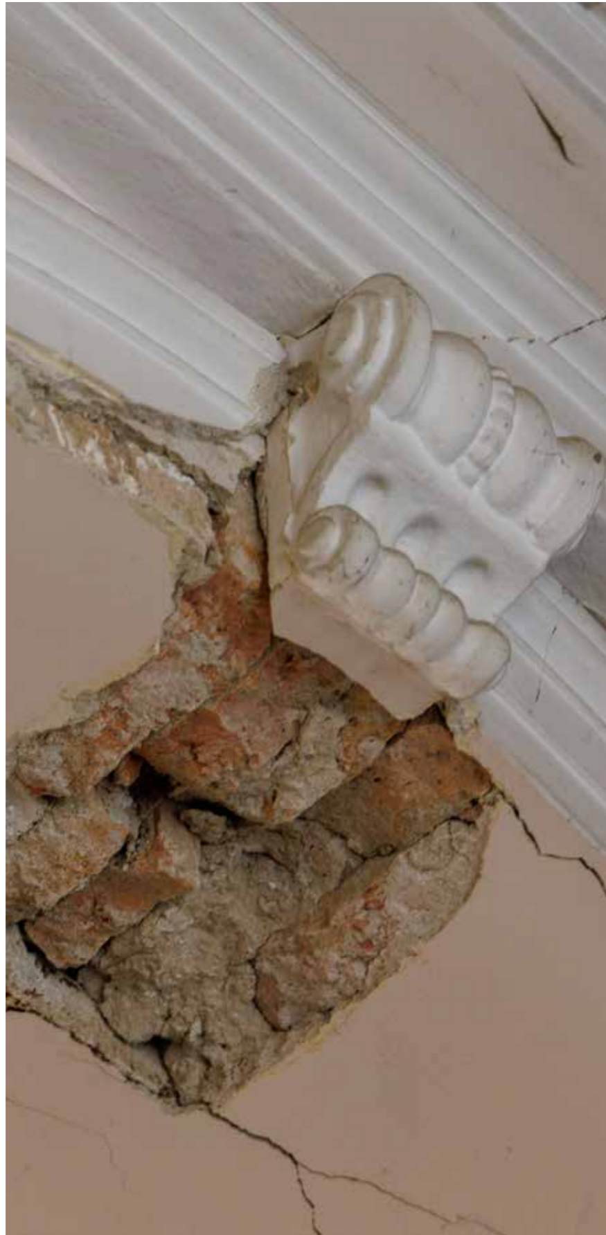
Oštećenja od potresa u interijeru
