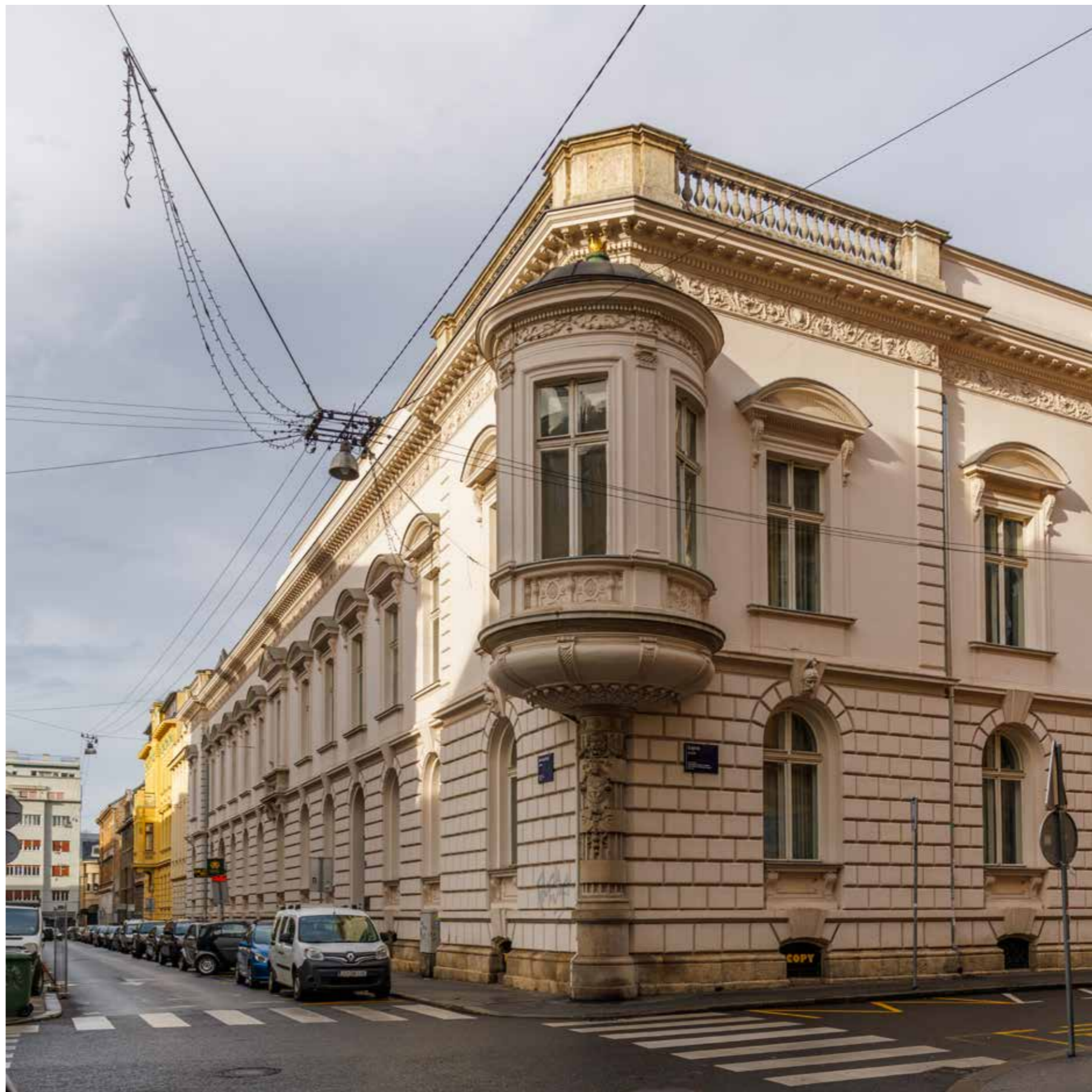
Južno i istočno pročelje s ugaonim erkerom
