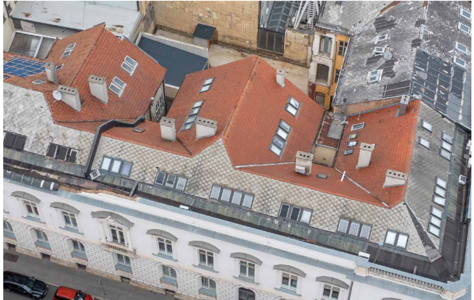
Pogled na krovnište, pokrov sivim eternitom treba ponoviti u novom materijalu (vlaknocementne bezazbestne ploče) uz istovjetni format i način slaganja
