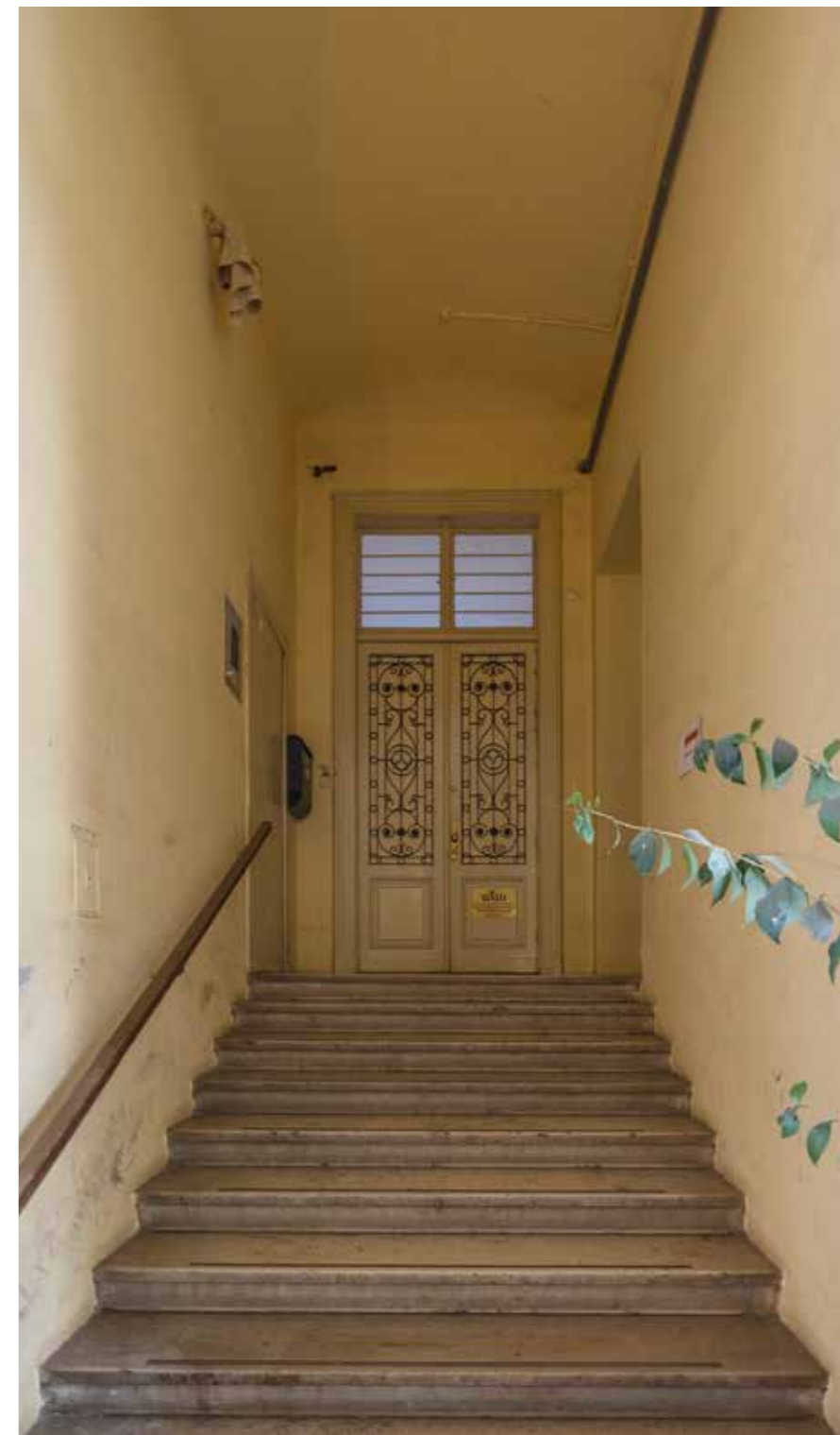
Ulaz iz veže u zapadni dio prizemlja
