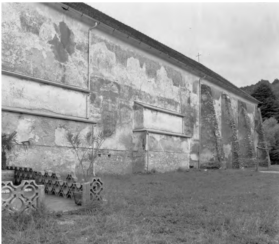
SJEVERNO PROČELJE CRKVE S "KAPELAMA" I UPORNJACIMA
