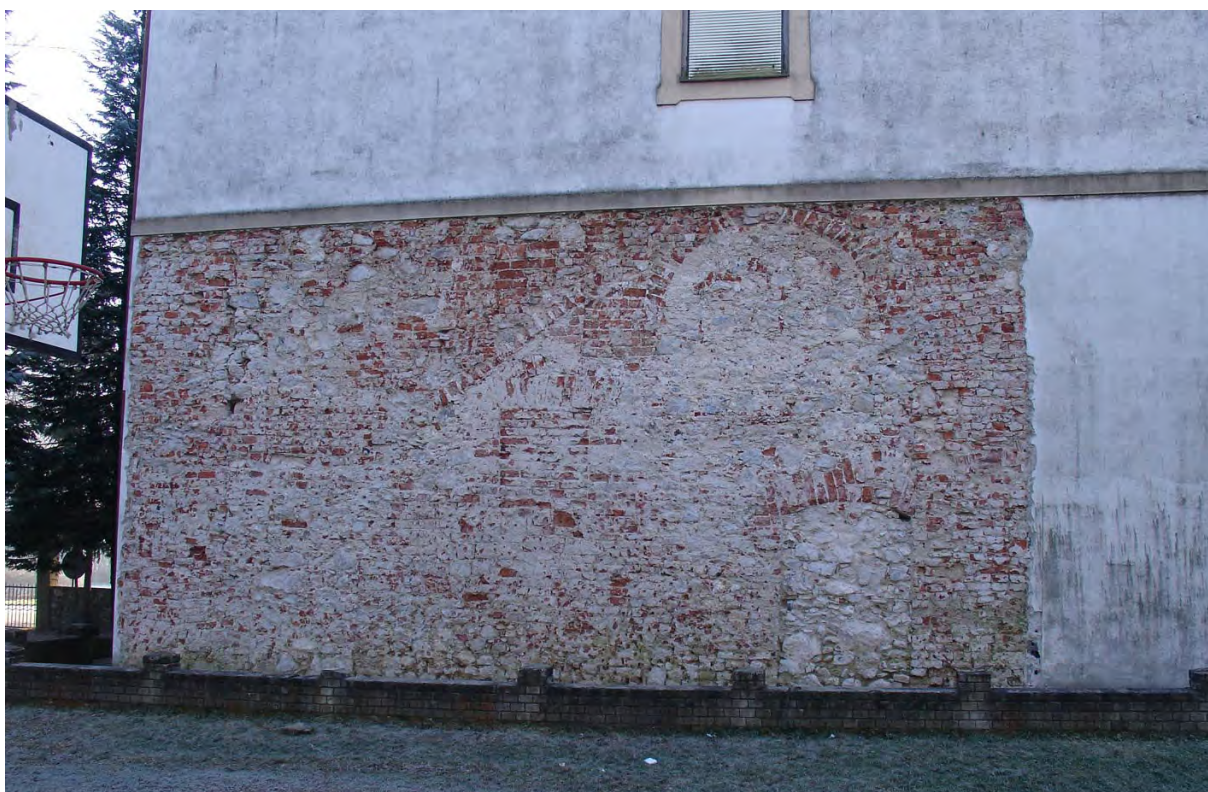
POGLED NA SJEVERNI ZID SAKRISTIJE SA ZAZIDANIM RANIJIM OTVORIMA
