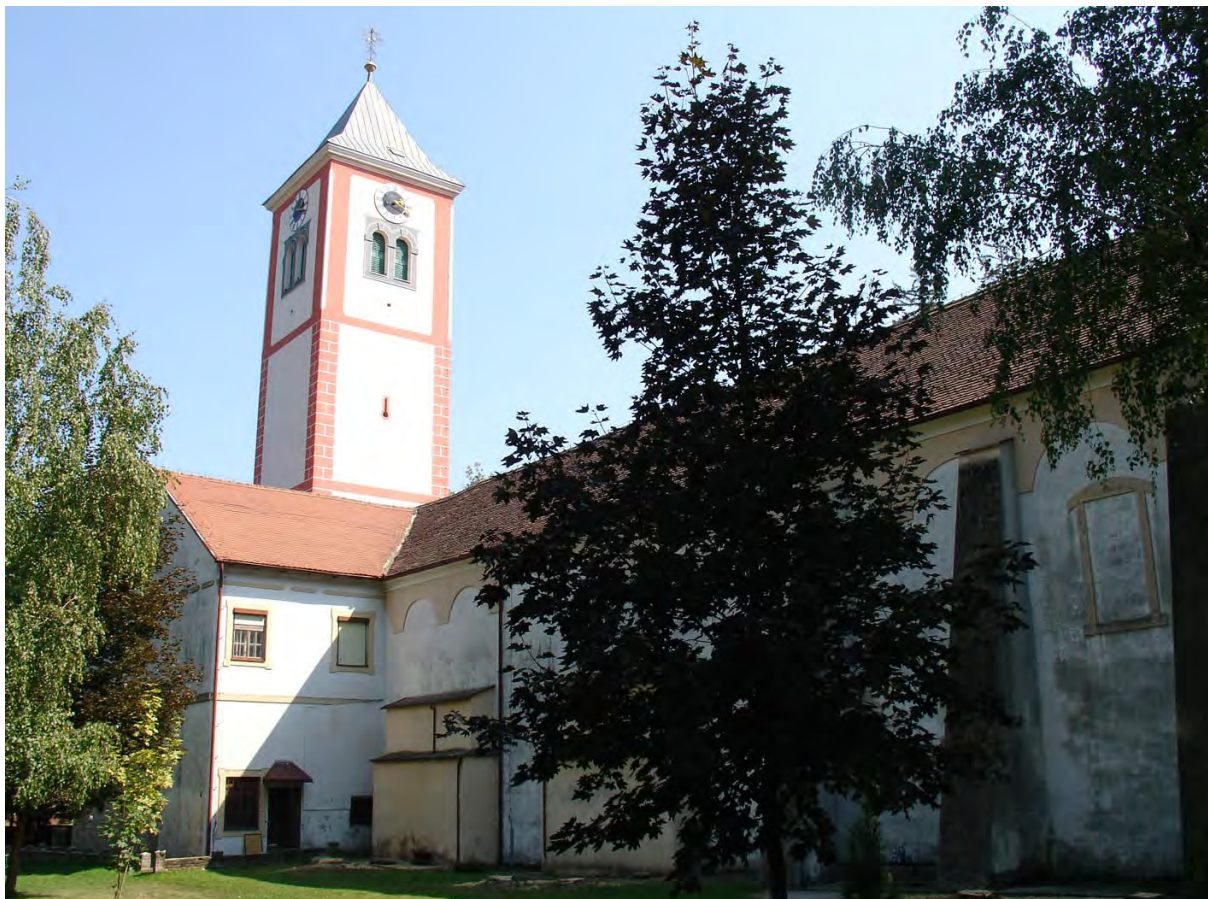
POGLED SA SJEVEROZAPADA NA SJEVERNO PROČELJE CRKVE, ZVONIK I DOGRADNJU "ISTOČNOG KRILA"
