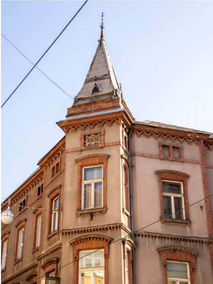
Kuća Rossipal, Medulićeva 2, ugaoni toranj
