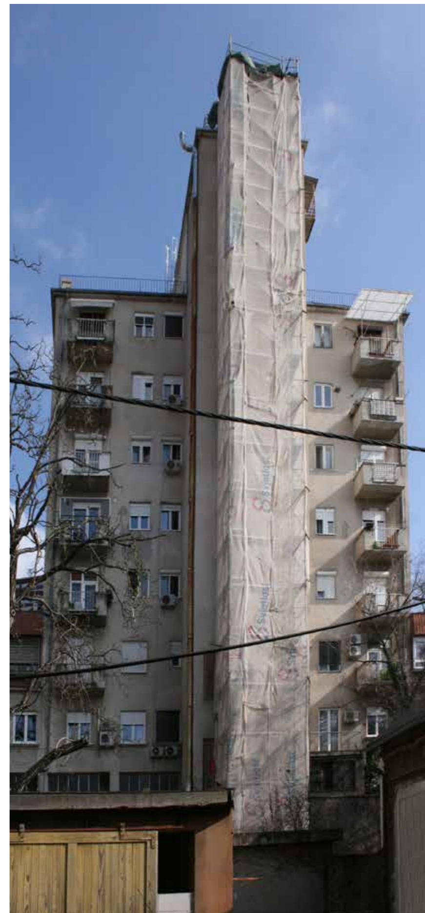
Prva dvorišna zgrada, zapadno pročelje
