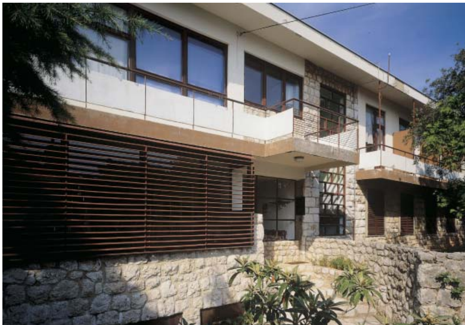
Dogradnja i pregradnja oporavilišnog doma Zanatlija / The Craftsmen Sanatorium extension and reconstruction , Crikvenica, Radićeva 152, 1956-57. (foto: Damir Fabijanić)
