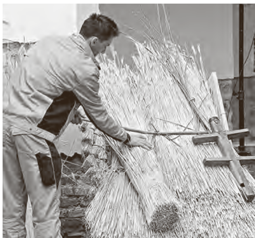
↑ Presentacija izrade pokrova od slame u sklopu radionice, FOTO G. Jerabek
