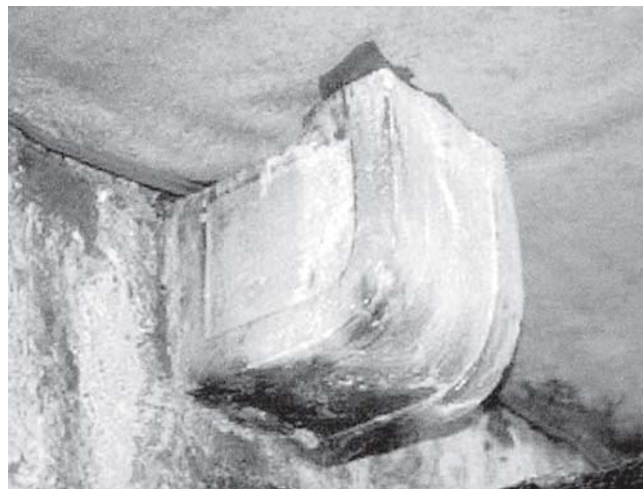
Konzola udubljenog profila sa zubom za nošenje grede odrine, zapadno pročelje kuće uz nekadašnji perivoj Cavetto-moulded console with a dentil supporting the beam of the pergola, west façade of the house beside the former park
