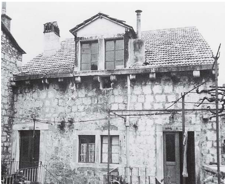
Kat i krov zapadnog pročelja kuće uz nekadašnji perivoj, sredina 20. stoljeća (Stara fototeka Konzervatorskog odjela u Splitu)
