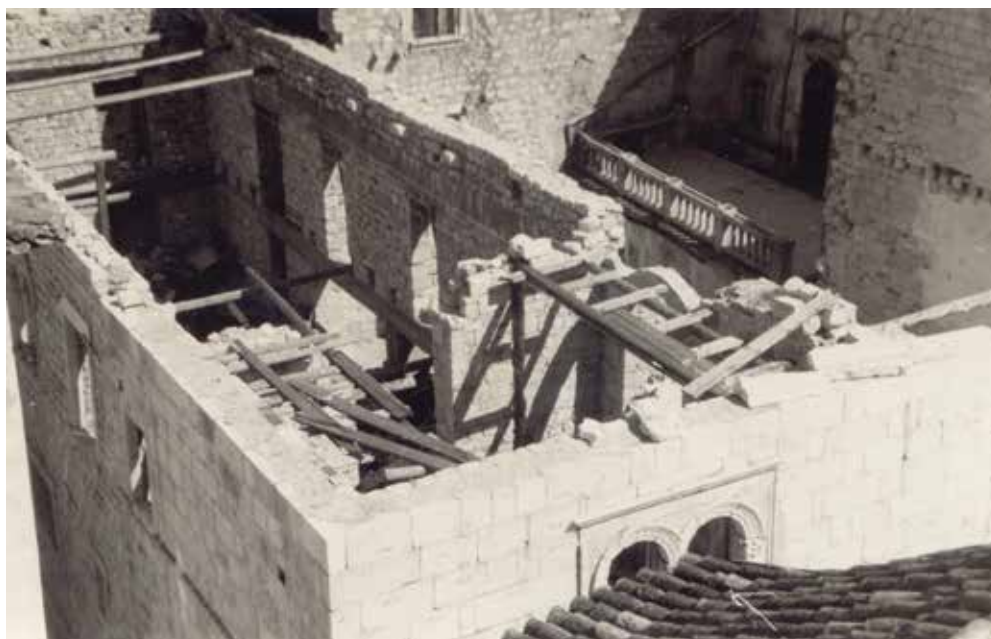
10 Stanje palače tijekom građevinskih radova, fotodokumentacija Konzervatorskog zavoda u Rijeci, 1953. State of the palace during the restoration works, photo-documentation of the Conservation Institute in Rijeka, 1953
