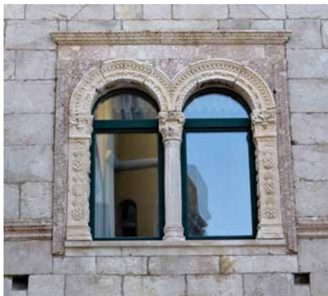
5 Renesansna bifora na prvom katu istočnog pročelja kneževe kule (foto: N. Vasić, 2016.) Renaissance bifora on the first floor, east façade of the rector's tower
