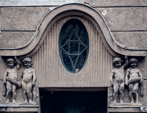
Ulaz u zgradu Hipotekarne banke u Prilazu Gjure Deželića 44, 1910.
