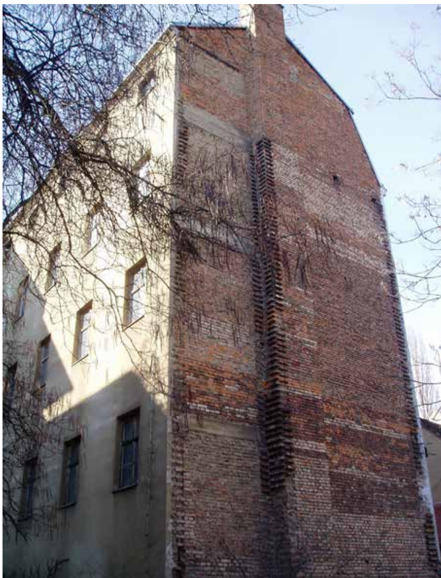
Istočno nedovršeno pročelje Ivekovićeve zgrade
