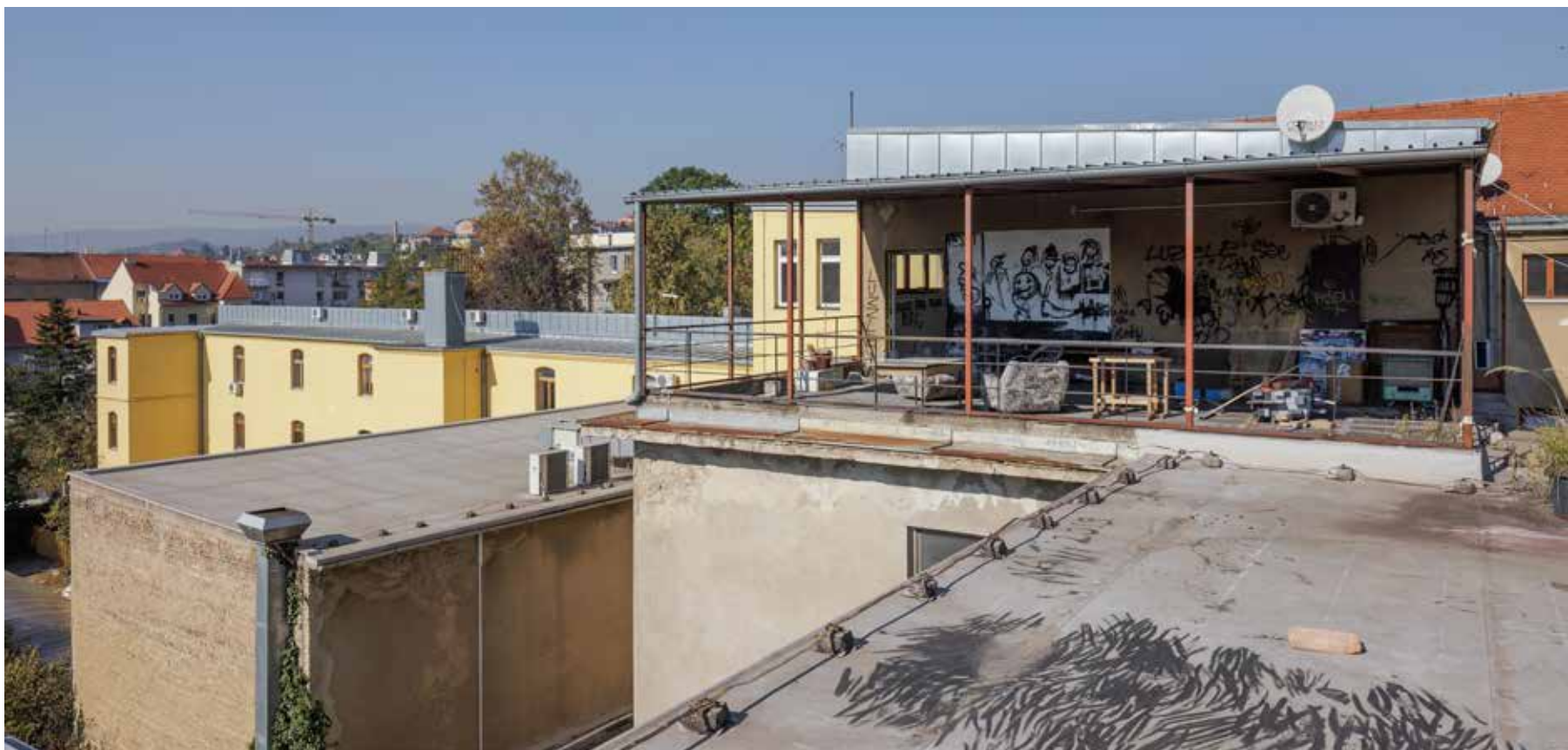
Krov akt-sale u Geršićevoj zgradi • Krov s nadstrešnicama na Geršićevoj zgradi
