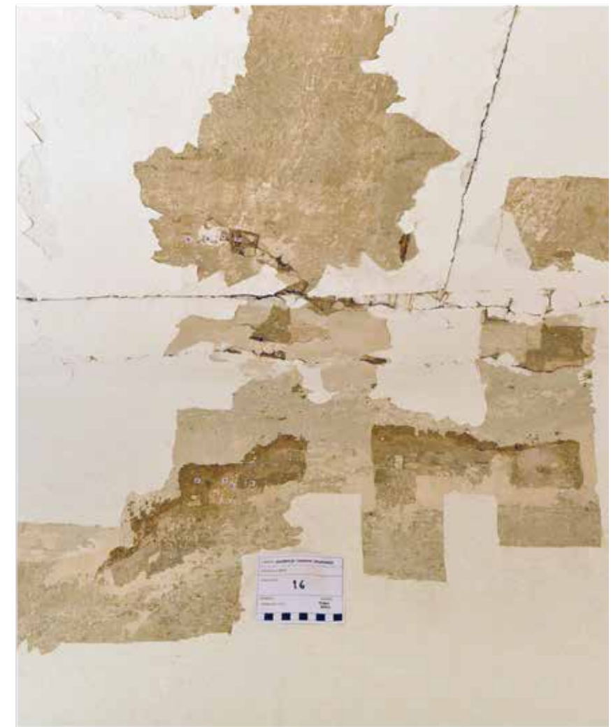
Foto br. 5 spoj zida i stropa, hodnik, I kat - zapad, sonda broj 16.
