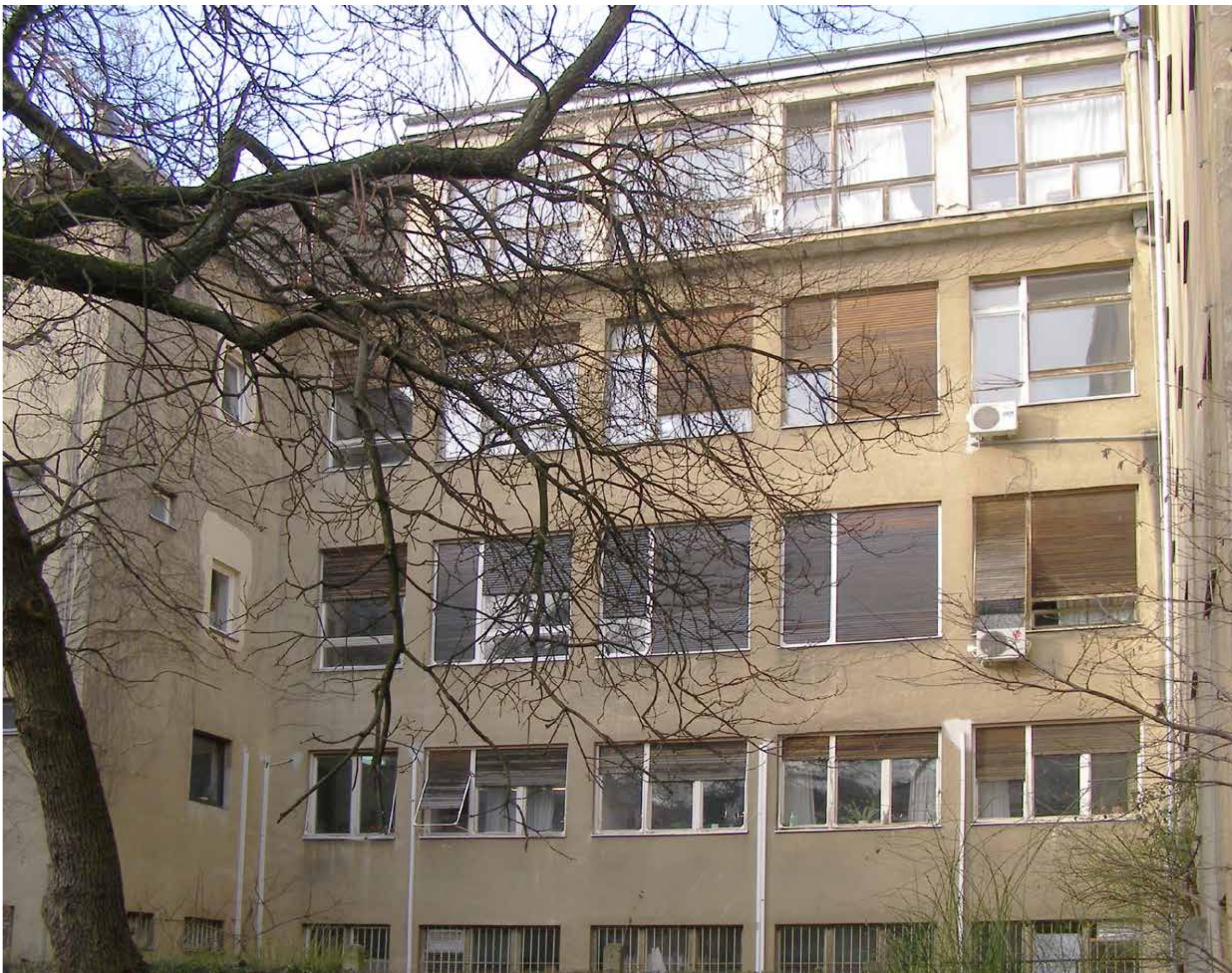
Istočno pročelje dogradnje prema projektu Ive Geršića, 1953.–1957.
