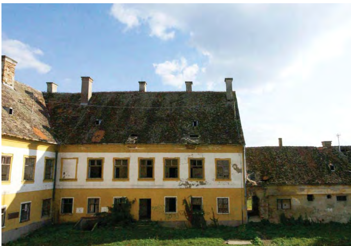
Sjeverno pročelje južnog krila, 2011.
