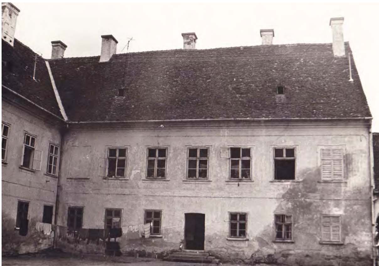
Sjeverno pročelje južnog krila, 1967.
