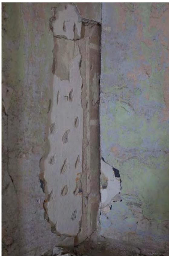
Nalaz uglovnog oslika sjevernog krila - kat, sjeveroistočni ugao prostorije 48, 2011.
