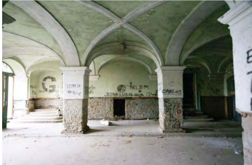
Pogled na sjeverni zid veže, 2011.
