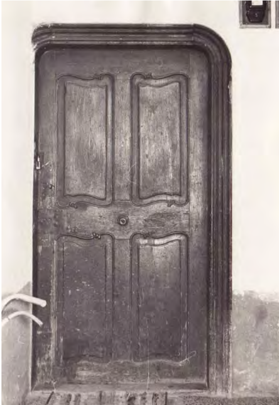
Vrata na sjevernom zidu prostorije 18, 1967.
