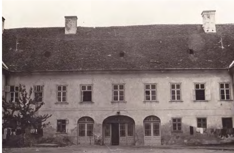
Zapadno pročelje istočnog krila, 1967.
