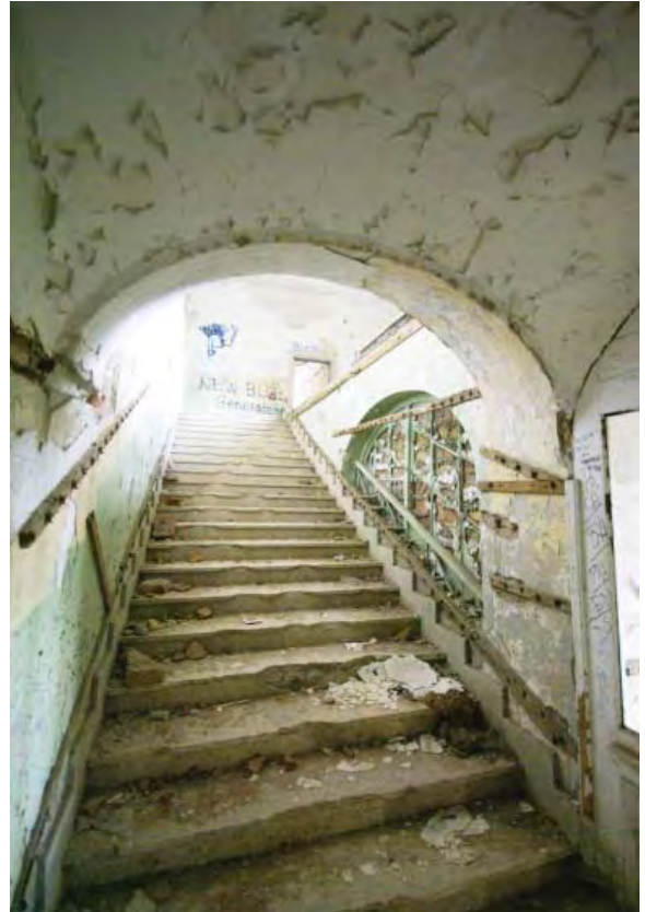
Pogled na zapadni zid stubišta, prostorija 43, 2011.
