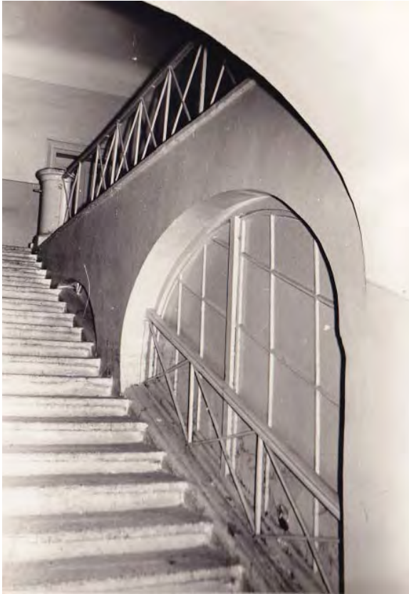
Pogled na zapadni zid stubišta, prostorija 43, 1967.
