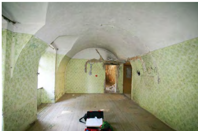
Bačvasti svod sa susvodnicama - prostorija 33, 2011.
