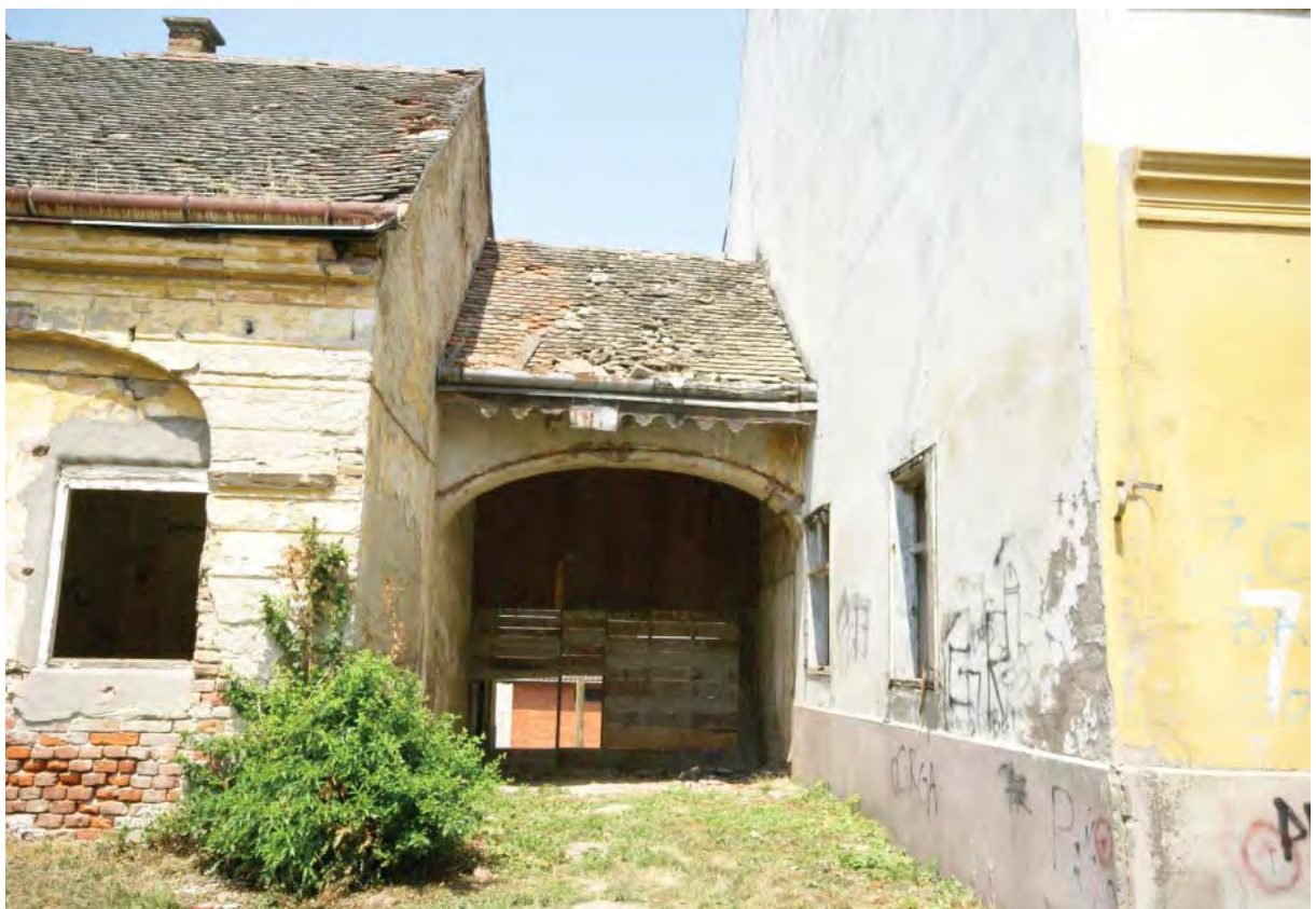
Spoj sjevernog krila i sjeverne gospodarske zgrade, 2011.
