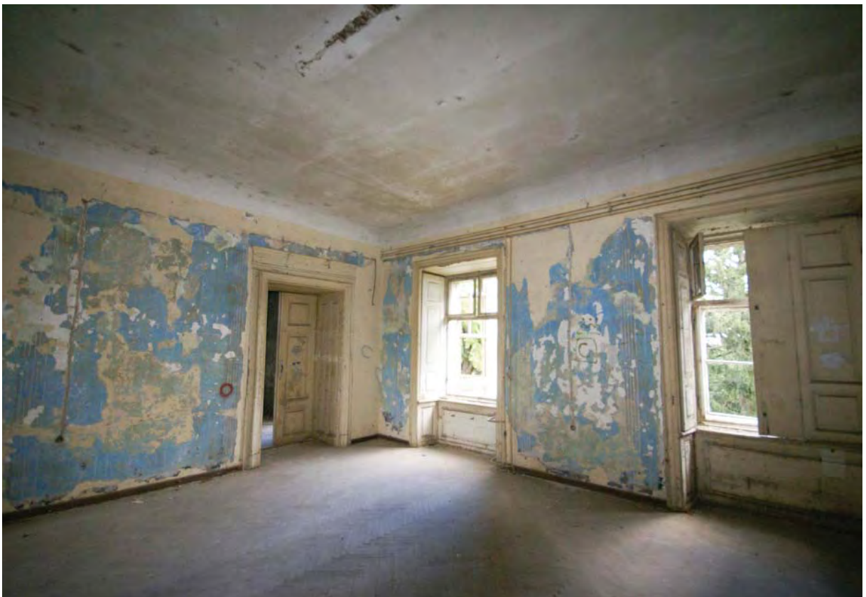
Tragovi bijelog oslika na plavoj podlozi na zidovima prostorije 68 na katu, 2011.
