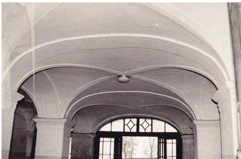
Pogled na svod veže, 1967.
