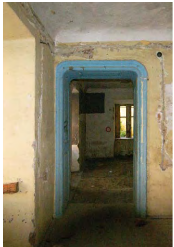
Vrata na zapadnom zidu prostorije 18, 2011.
