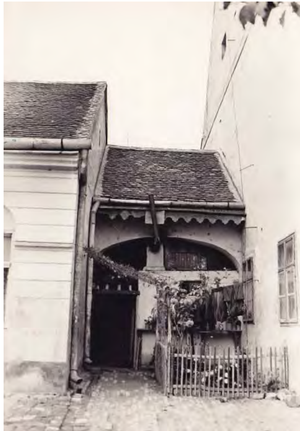
Spoj sjevernog krila i sjeverne gospodarske zgrade, 1967.
