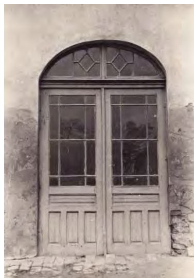
Bočna vrata na zapadnom pročelju istočnog krila, 1967.
