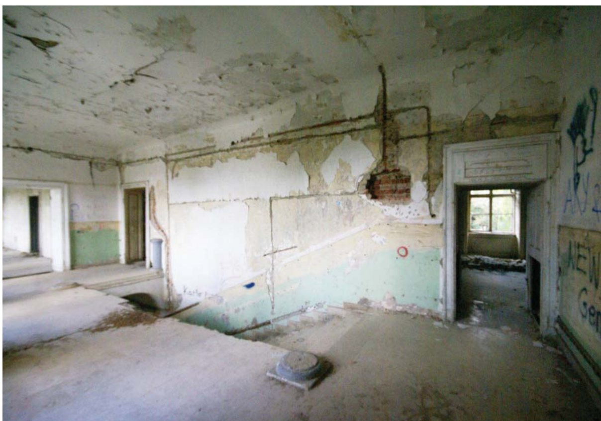
Stubište na katu južng krila, prostorija 44, pogled prema istoku, 2011.
