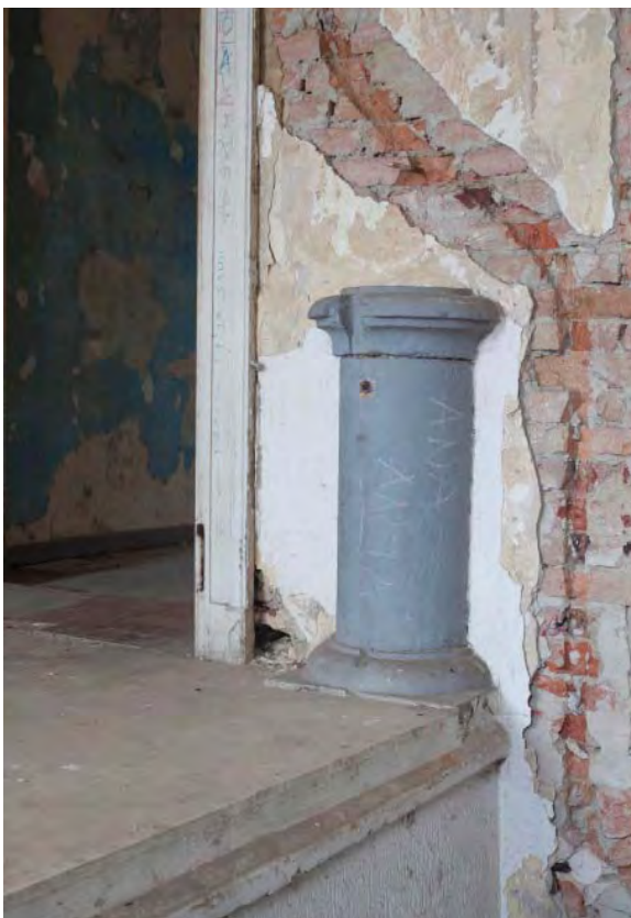
Pogled na zapadni zid stubišta, prostorija 43 - ostatak stupa ograde, 2011.
