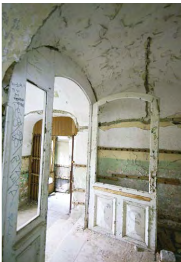
Vrata na zapadnom zidu stubišta, 2011.
