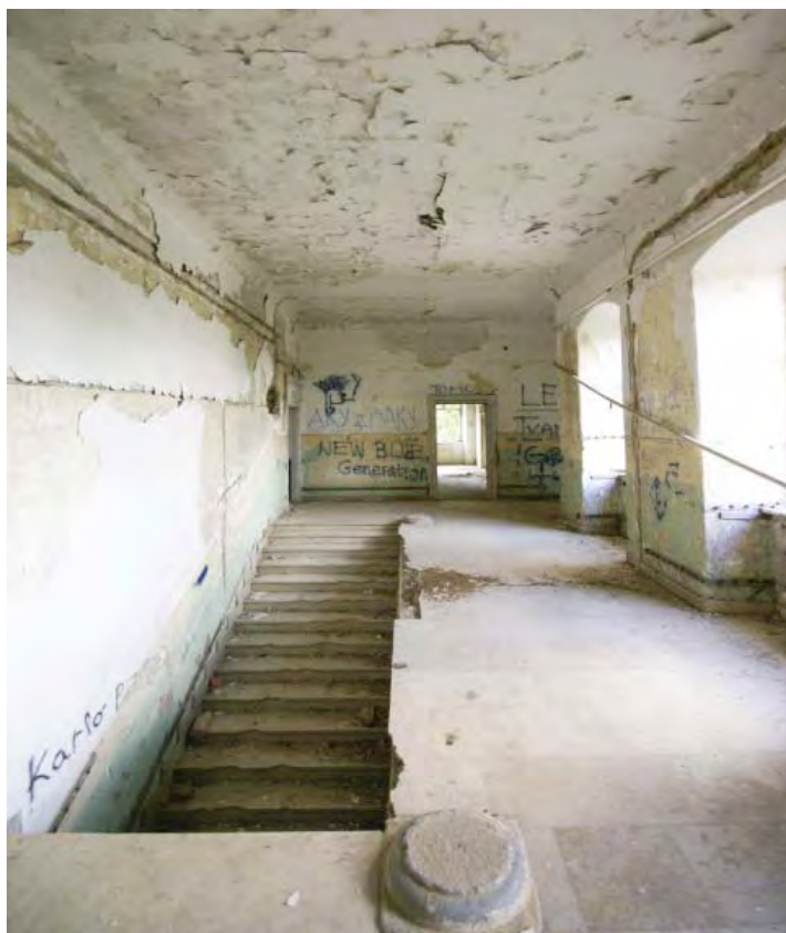
Stubište na katu južng krila, prostorija 44, pogled prema jugu, 2011.
