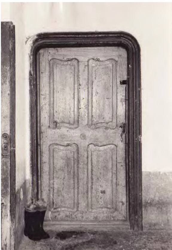
Vrata na zapadnom zidu prostorije 18, 1967.
