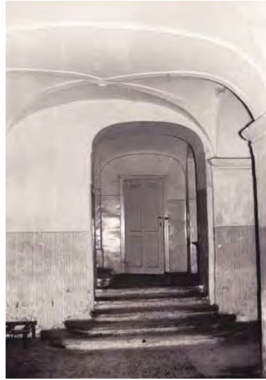
Ulaz u stubište - zapadni dio južnog zida veže, 1967.
