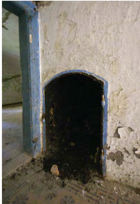
Otvor ložišta, prostorija 39, 2011.
