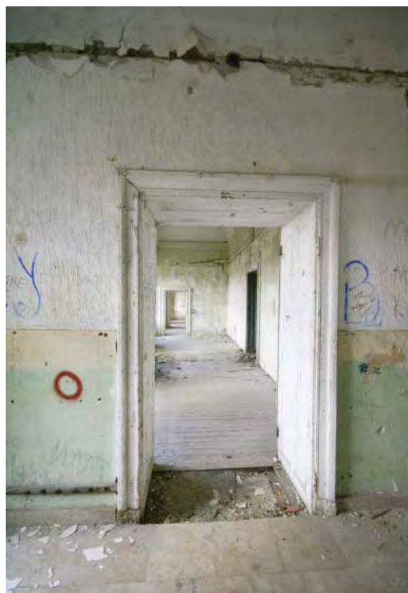
Okvir vrata na sjevernom zidu prostorije 44, 2011.
