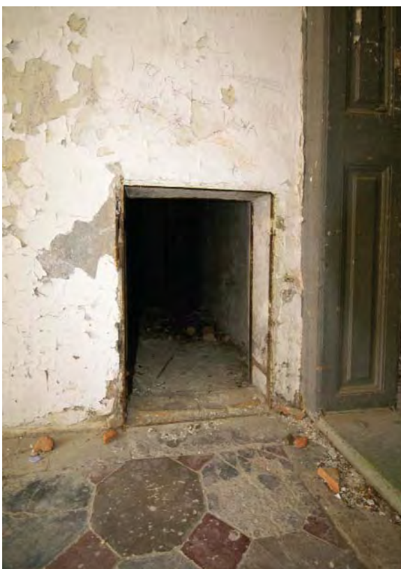
Otvor ložišta, prostorija 63, 2011.
