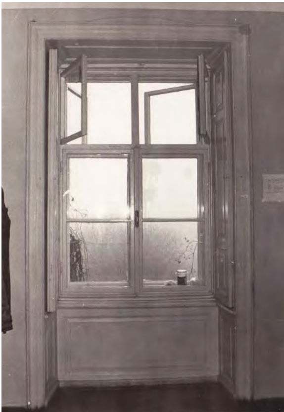
Prozori s unutarnjim klapnicama na sjevernom, istočnom i južnom pročelju kata dvorca, 1967.
