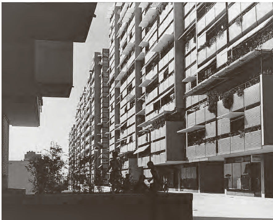
← Stambene zgrade, Split 3, arhitekt Ivo Radić, 1972.
