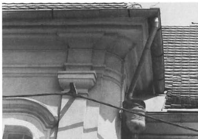
Krovni vijenac i sabirni lonac (1833) (foto: Krešimir Tadić) Cornice and gutter (1833) (Photo Krešimir Tadić)
