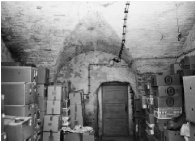
Dio svoda i susvodnica sjeverne podrumске prostorije uličnog krila. Vidi se naknadno otvoren prolaz prema dijelu podruma pod dvorišnim krilom; snimo A. Žmegač
