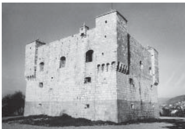
Nehaj, južno i istočno pročelje Nehaj, south and east façade
