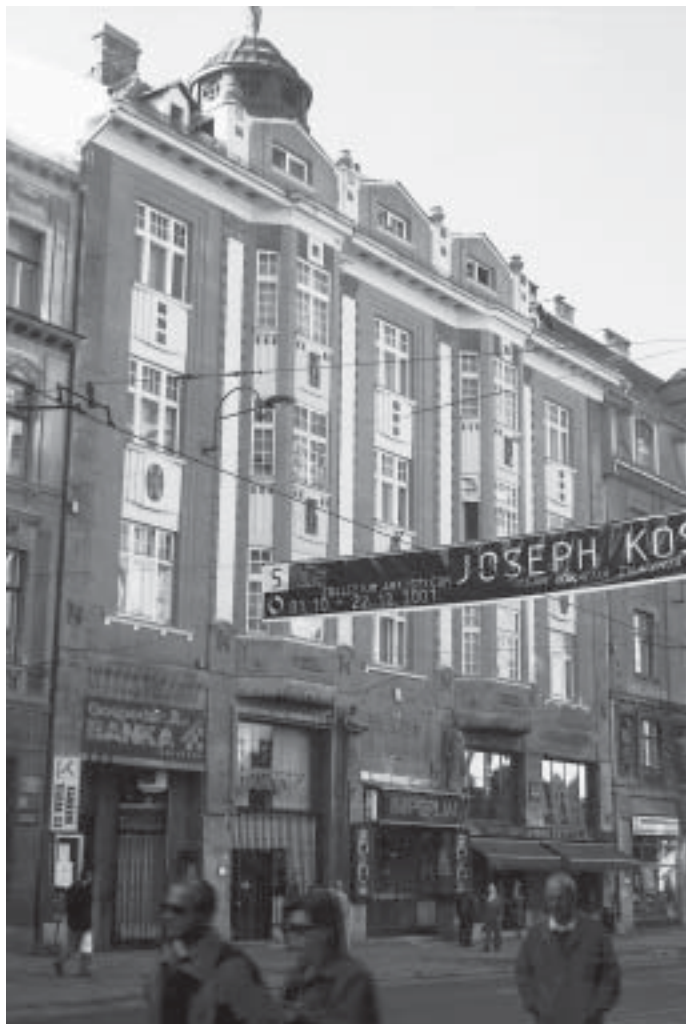
D. Sunko, Napretkov zakladni dom , Sarajevo, pročelje sjeverne zgrade (foto: M. Bagarić)
