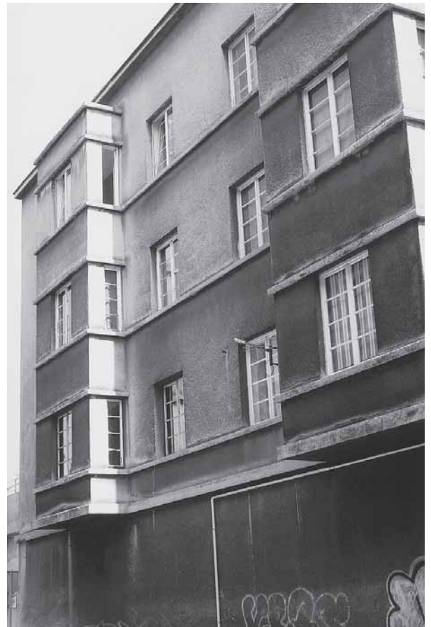
Rijeka, stambena trokatnica Gaber, Šetalište 13. divizije 5, južno pročelje (foto: JLB) Rijeka, The Gaber house at 13 th Division's Promenade 5
