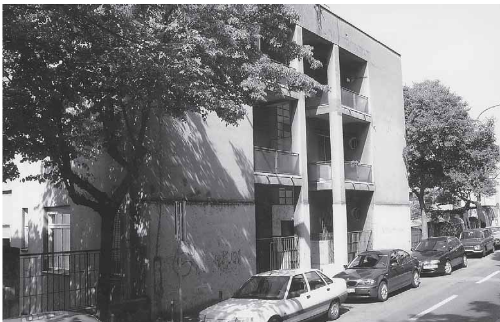
Rijeka, stambeno-poslovna dvokatnica Grgurić, Šetalište 13. divizije 20, ulično pročelje (foto: JLB)
