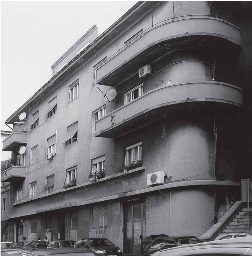
Rijeka, stambeno-poslovna trokatnica Emili, Šetalište 13. divizije 9, južno pročelje (foto: JLB) Rijeka, The Emili house 13 th Division's Promenade 9
