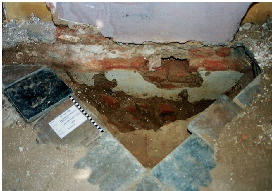
7. Palača Pejačević, konzervatorska istraživanja, sonda u podu hodnika na katu (svod trijema se naslanja na obojenu žbuku)
