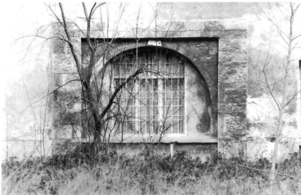
Koprivnica, nova Oružana, detalj južne fasade
