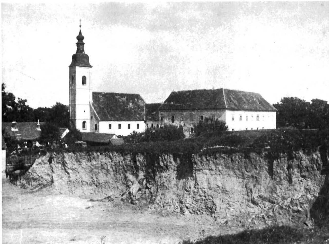
Koprivnica, franjevački kompleks uz bedeme
