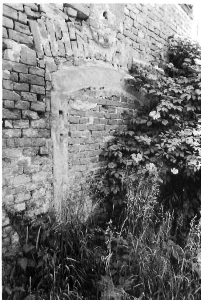
Koprivnica, naknadno zazidani ulaz u gospodarski objekt
