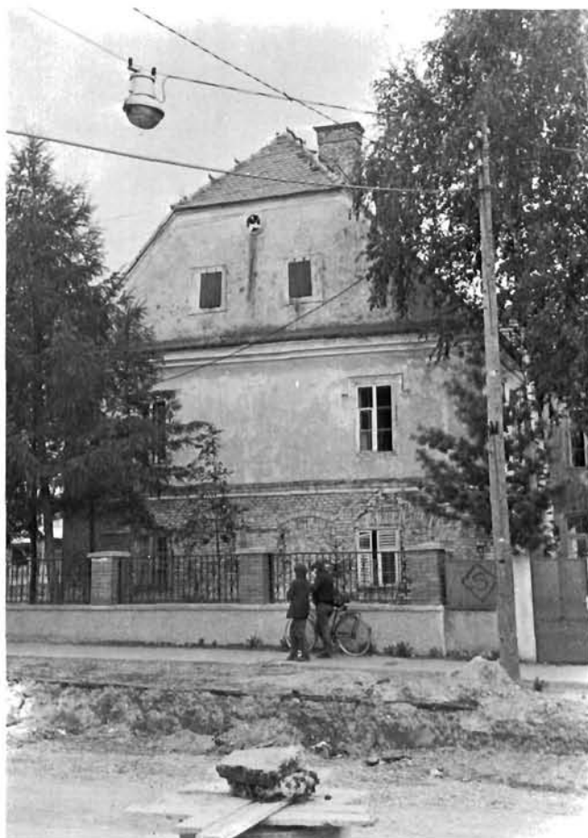
Prelog, zgrada župnog dvora — sjeverno pročelje nakon skidanja žbuke
