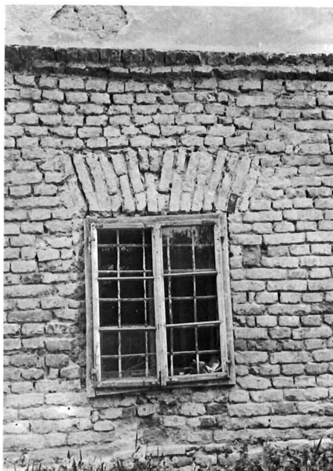
Prelog, zgrada župnog dvora — prozor na istočnoj strani prizemne zone južnog pročelja nakon skidanja žbuke
