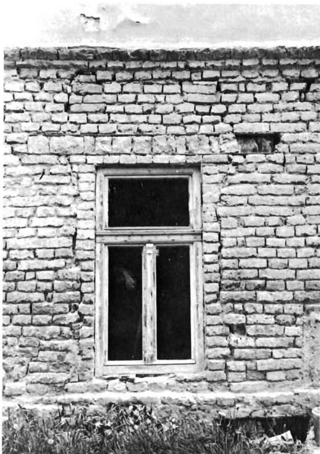
Prelog, zgrada župnog dvora — detalj prizemlja južnog pročelja, naknadno ugrađeni prozor nakon skidanja žbuke
