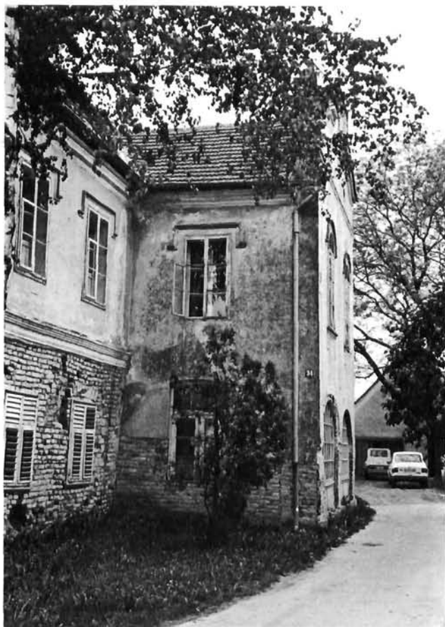
Prelog, zgrada župnog dvora — sjeverna strana zapadnog pročelja; vidi se zazidani trijem središnjeg rizalita
