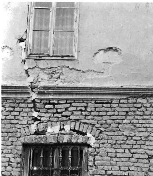
Prelog, zgrada župnog dvora — detalj na sjevernom dijelu istočnog pročelja u zoni prvog kata; na sondi se vidi donji dio slijepog prozora desno od novog prozora, detalj završne profilacije prozorskog okvira, trag otučene lezene ispod novog prozora i gruba naštrcana žbuka na zidnom platnu
